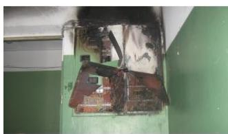
ты, расположенные в электроощите. Площадь пожара составила 0,5 кв. м. Причиной пожара послужило короткое замыкание электропроводки в электроощите.
