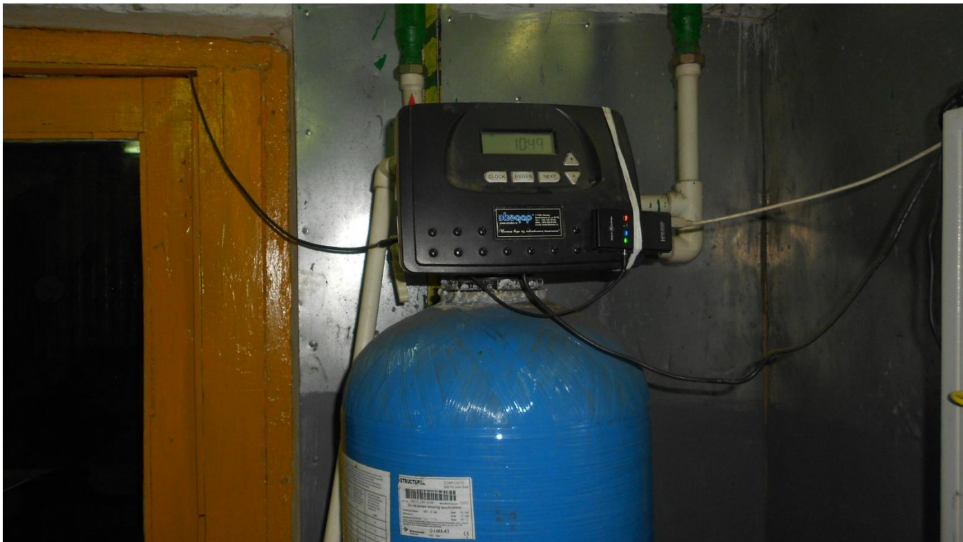
Рис 4 Система химической водоподготовки в котельной с. Дзякино
