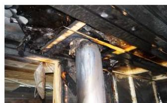
18.05.2019 в 21 час 50 минут на пункт связи пожарно-спасательной части №17 поступило сообщение о возгорании дома по адресу: Глазовский район, д. Качкашур, ул. Комсомольская. Повреждено потолочное перекрытие. Площадь пожара составила 3 кв.м. Причиной послужило неправильное устройство дымохода печи (отсутствие разделки).
