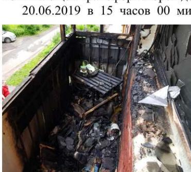
20.06.2019 в 15 часов 00 минут на пункт связи пожарно-спасательной части №17 поступило сообщение о возгорании на балконе по адресу: г. Глазов, ул. Короленко, 29 «б». В результате нарушения правил пожарной безопасности при проведении электросварочных работ гр. Т. повреждён балкон, закопчены стены и потолок в квартире на площади 14 кв.м.
